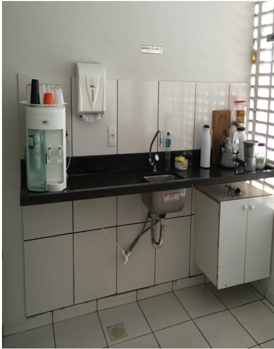
Ausência de rejunte na cerâmica da parede e do piso no refeitório dos funcionários
