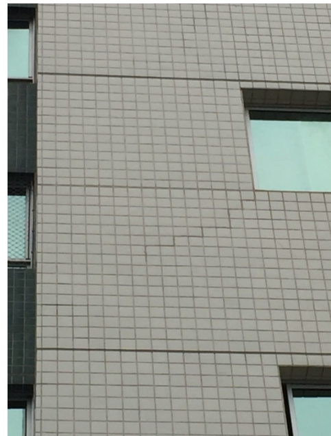
Indícios de reparo no rejunte das cerâmicas na fachadas do bloco C
