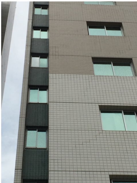
Indícios de reparo no rejunte das cerâmicas na fachadas do bloco C
