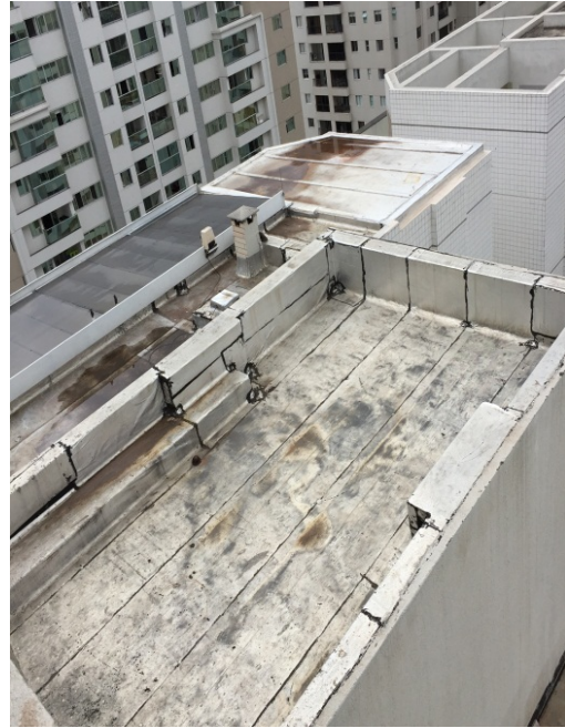
Fechamentos de cobertura – alterados pelos proprietários – cobertura bloco D
