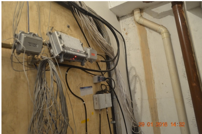
Quadro PRINCIPAL TELEFONIA – Subsolo – equipamentos instalados com sobreaquecimento.
