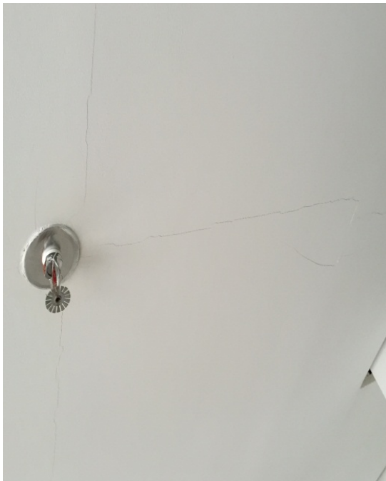
Trinca no forro de gesso e no azulejo da parede no piso da lavanderia
