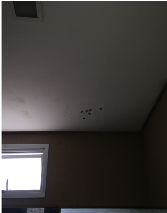
Sinal de infiltração e trinca banheiro salão de festas bloco C
