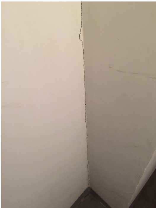
Trinca e junta de dilatação danificada na garagem 1ª. Sub solo
