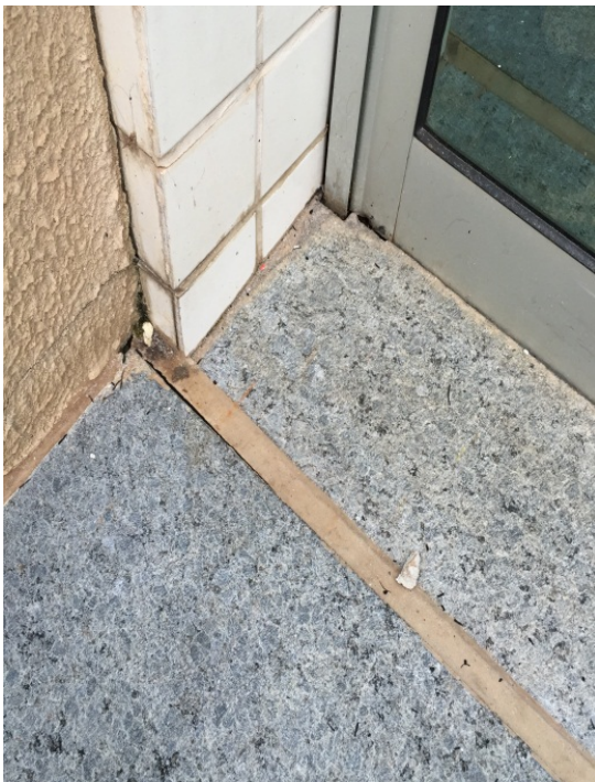
Porta de entrada salão de jogos infantil com pontos de infiltração na junta de dilatação
