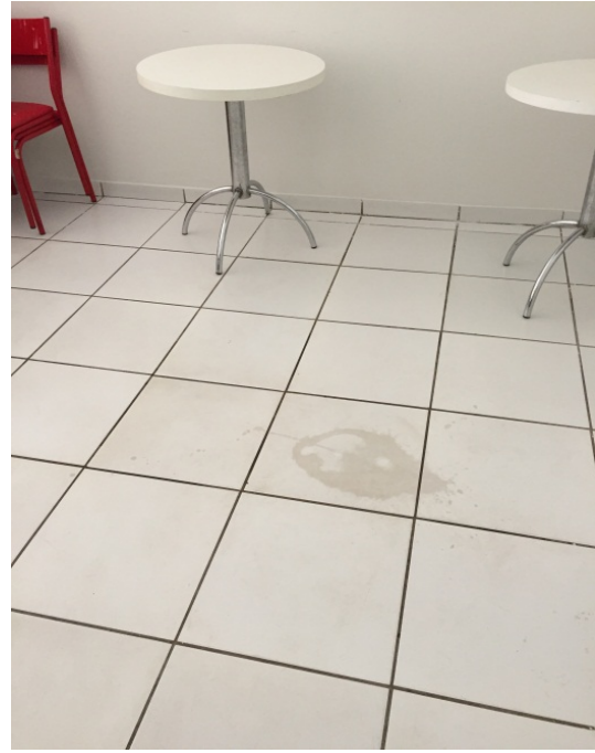
Piso manchado e indício de infiltração no refeitório dos funcionários
