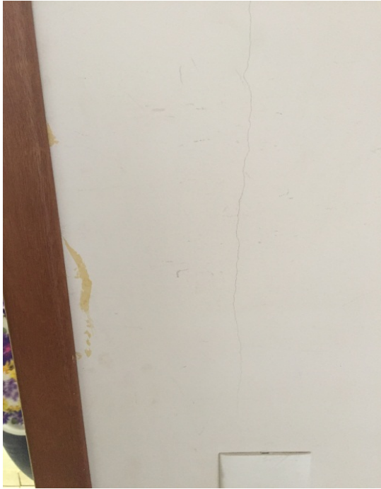
Acabamento da porta e forro de gesso trincado
