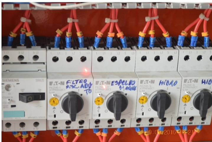
Quadro Casa de Máquinas-Piscina-Bar com disjuntores adulterados gerando sobreaquecimento
