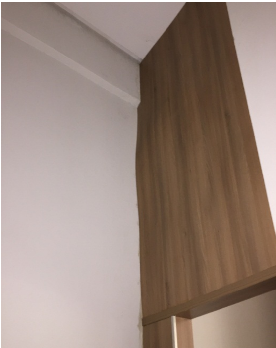
Painel de madeira danificado por água - Sinal de infiltração banheiro salão de festas bloco C
