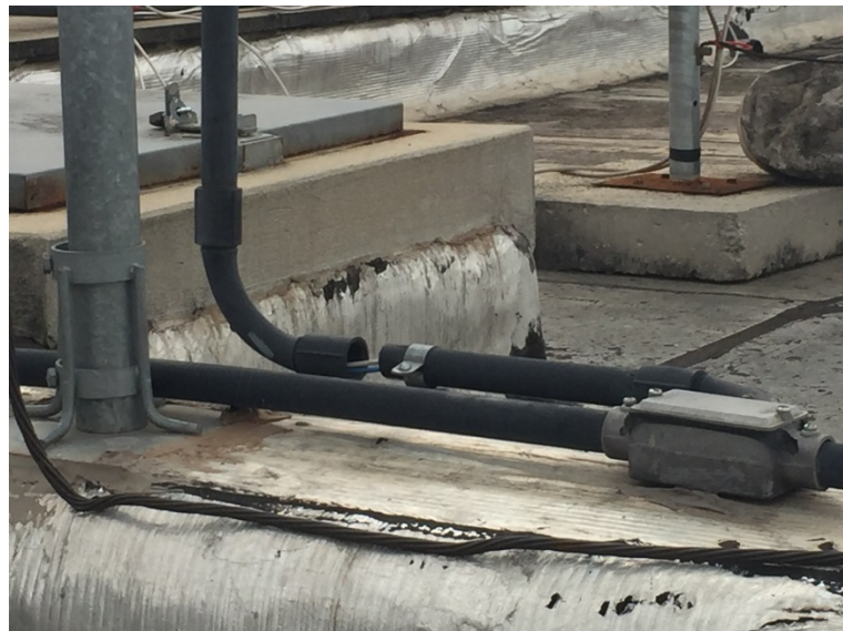
Aterramento executado pelo Condomínio perfurando a manta de impermeabilização e fiação elétrica exposta - Cobertura bloco C
