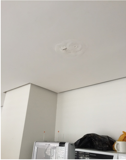
Piso manchado e indício de infiltração no refeitório dos funcionários
