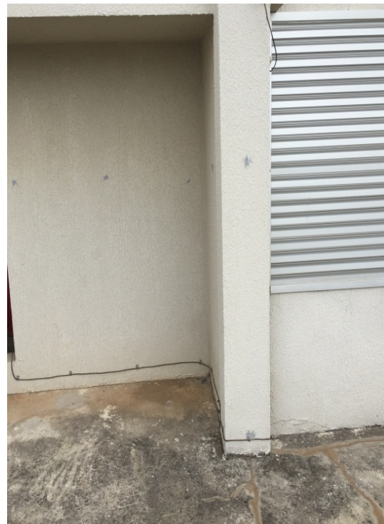
Aterramento executado pelo Condomínio – cobertura bloco C
