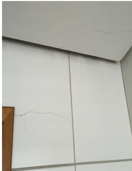
Trinca no forro de gesso e no azulejo da parede no piso da lavanderia
