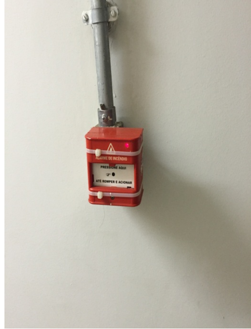
Pintura danificada e botoeira presa por fita plástica – 1º. Sub solo, corredor de acesso as áreas comuns, em frente a bricolagem
