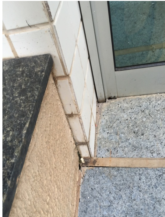
Porta de entrada salão de jogos infantil com pontos de infiltração na junta de dilatação
