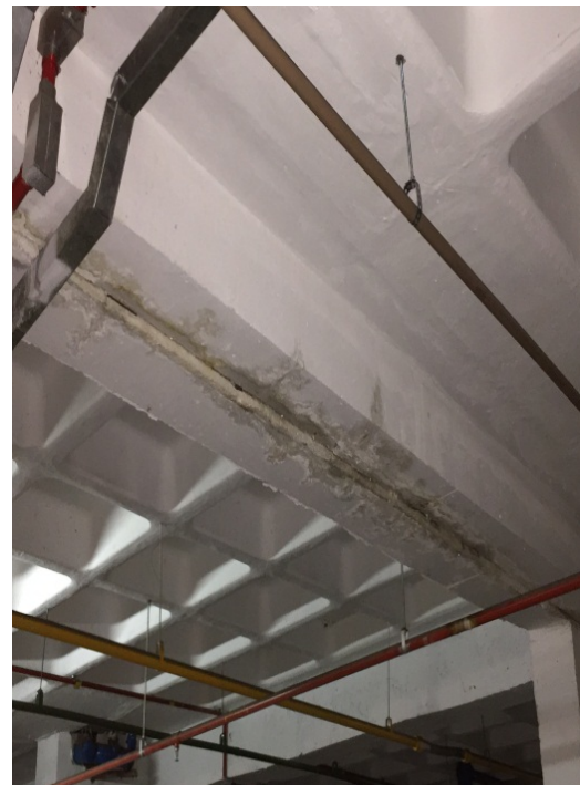
Presença de umidade na junta de dilatação – teto 1º subsolo
