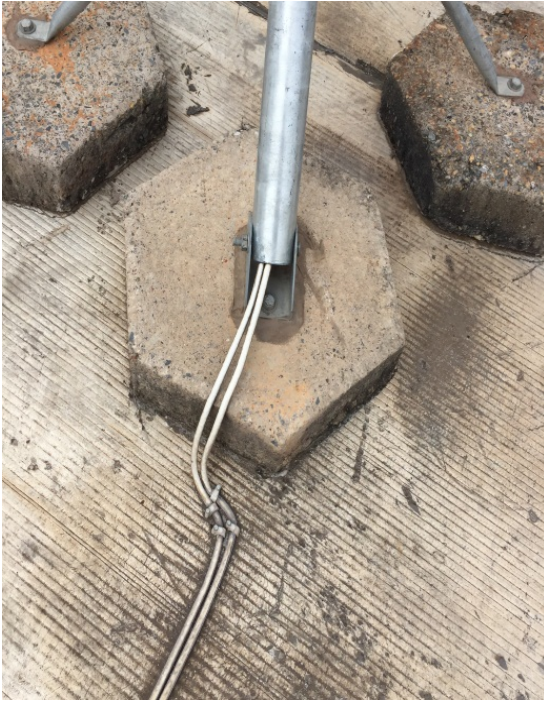
Danos na manta de impermeabilização – furada com fixação do cabeamento das antenas de empresas como SKY, CLARO-OI – alteração na cobertura realizada pelo proprietário – cobertura bloco D
