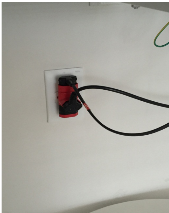
Ligação elétrica contrária a Norma no refeitório dos funcionários
