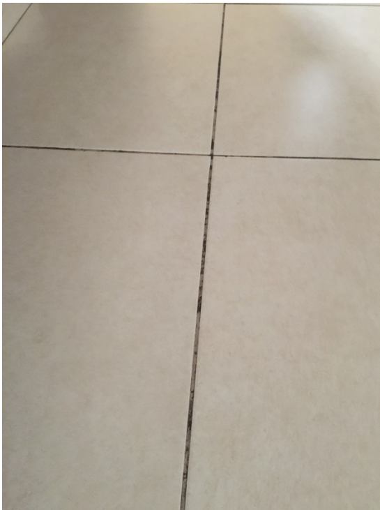
Falhas no rejunte do piso do salão de festas – bloco C
