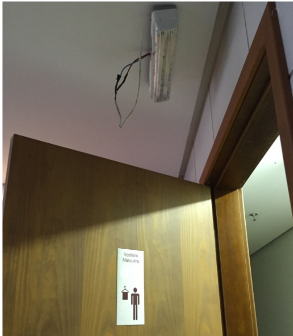
Fiação exposta e maçaneta quebrada no vestiário masculino
