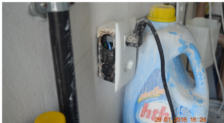
Quadro Casa de Máquinas-Piscina-Bar – Aquecedor Adulto com instalações (aparentemente) adulteradas
