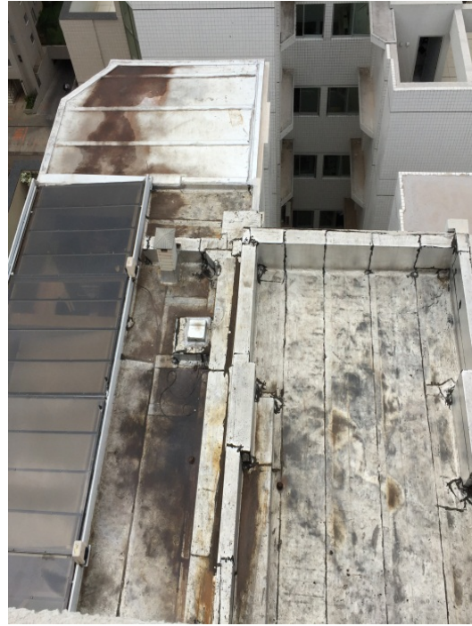
Danos na manta de impermeabilização – furada com fixação do cabeamento das antenas de empresas como SKY, CLARO-OI – alteração na cobertura realizada pelo proprietário – cobertura bloco D
