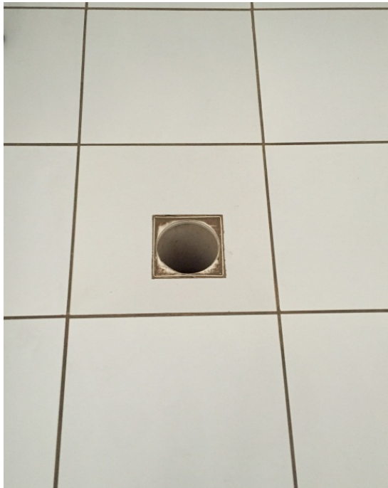
Ausência de acabamento do ralo no piso da lavanderia
