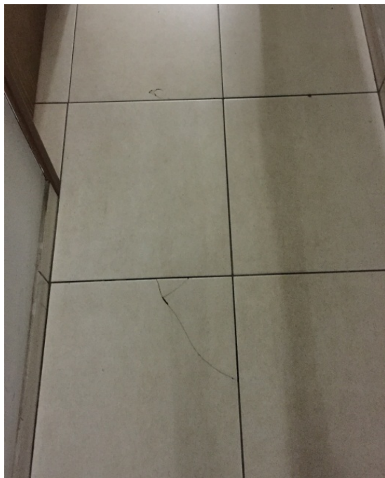
Piso trincado no 1º subsolo – corredor de acesso a áreas comuns
