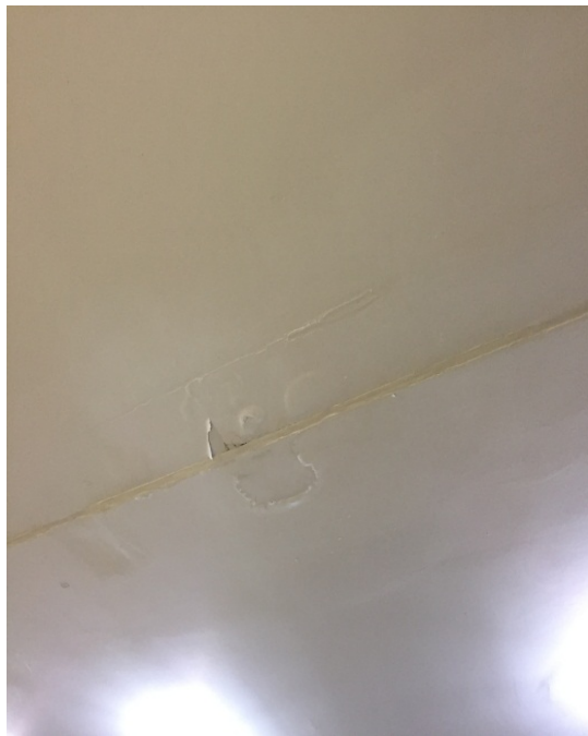
Ponto de infiltração no forro de gesso na garage band
