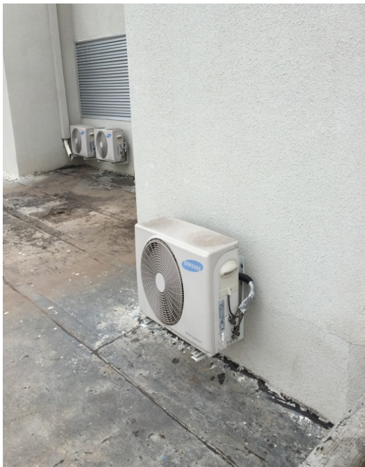
Instalação de ar condicionado cobertura bloco D
