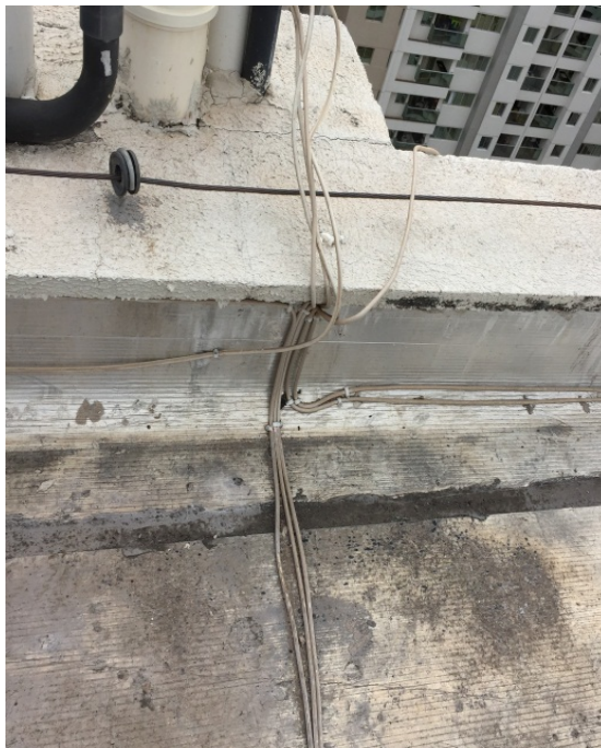
Danos na manta de impermeabilização – furada com fixação do cabeamento das antenas de empresas como SKY, CLARO-OI – cobertura bloco D
