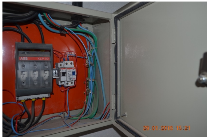
Quadros de Força dos Elevadores – Sem identificação dos circuitos.
