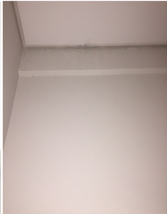
Painel de madeira danificado por água - Sinal de infiltração banheiro salão de festas bloco C
