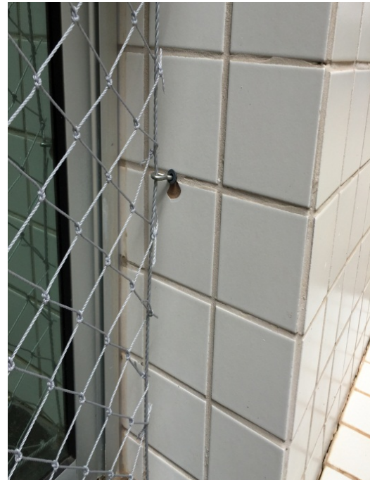
Furo sem calafetação na fachada na instalação de tela de proteção – salão de festas bloco D
