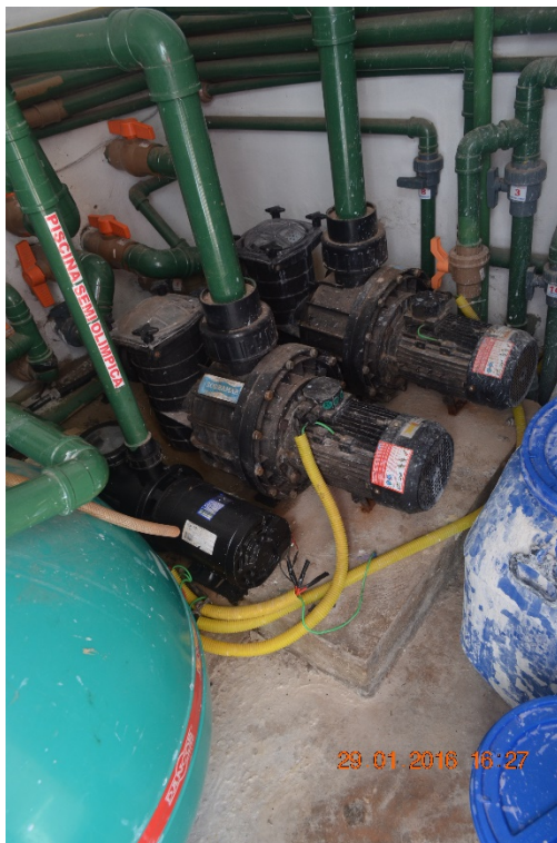
Casa de Máquinas com fiações expostas e sendo utilizada como depósito.
