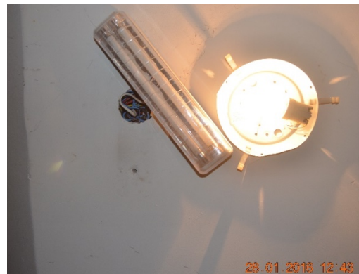
Fiação exposta e luminária quebrada - Escada no mezanino
