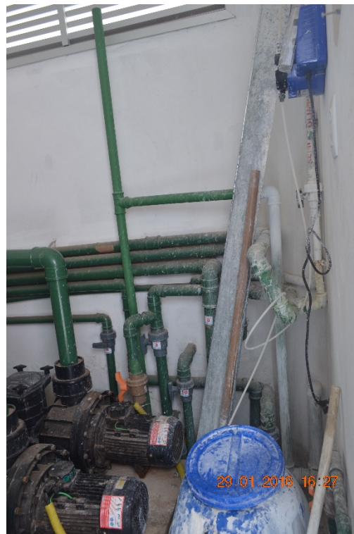
Casa de Máquinas com fiações expostas e sendo utilizada como depósito.
