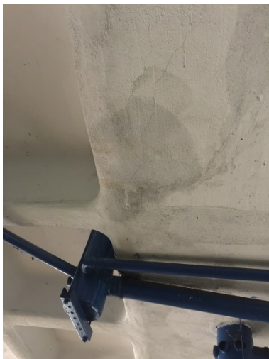
Ponto de infiltração próximo a rampa de veículo interdita no 1º. Subsolo
