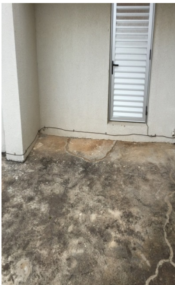
Aterramento executado pelo Condomínio perfurando a manta de impermeabilização e fiação elétrica exposta - Cobertura bloco C
