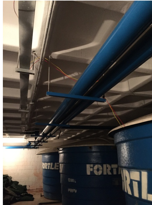
Fiação da boia do reservatório inferior alterada
