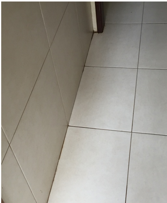
Banheiro masculino com ausência de rejunte no piso e Falha rejunte fachada banheiros
