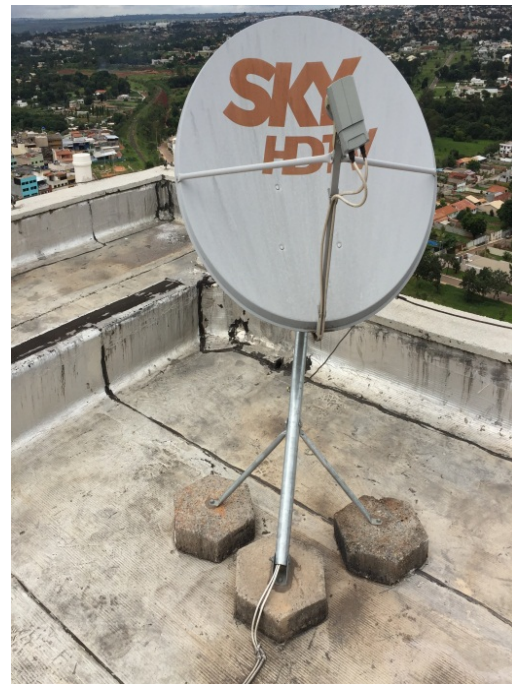
Danos na manta de impermeabilização – furada com fixação do cabeamento das antenas de empresas como SKY, CLARO-OI – cobertura bloco D
