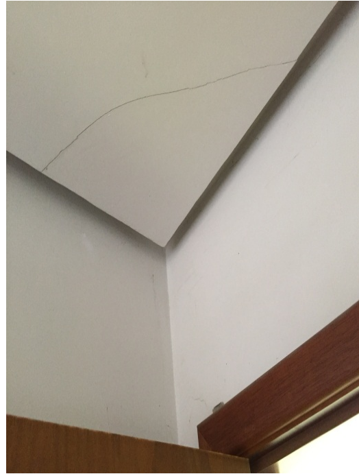
Acabamento da porta e forro de gesso trincado
