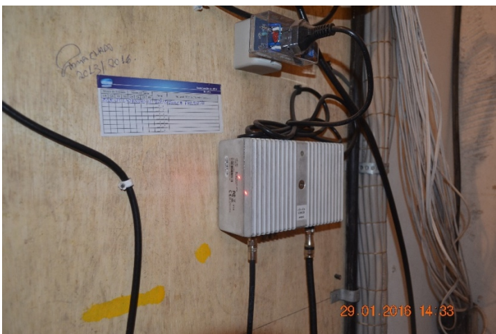
Quadro PRINCIPAL TELEFONIA – Subsolo – equipamentos instalados com sobreaquecimento.
