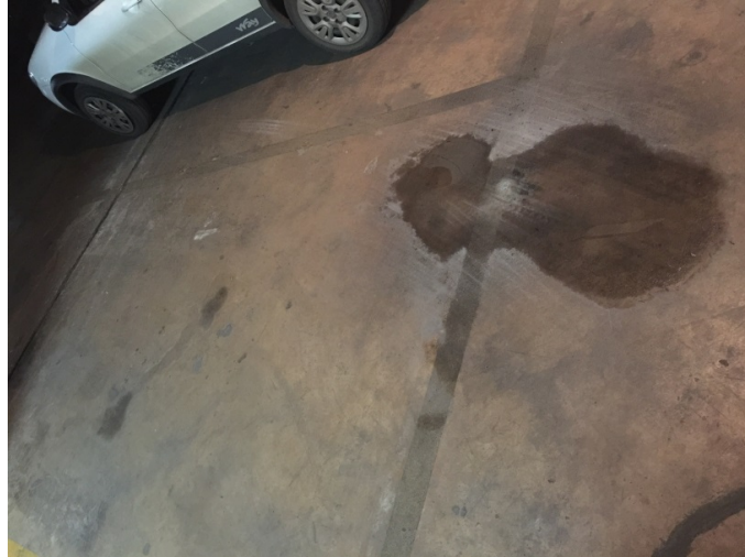
Ponto de infiltração próximo a rampa de veículo interdita no 1º. Subsolo
