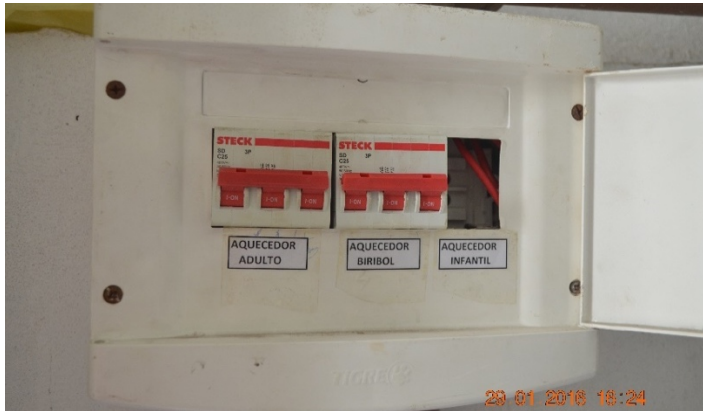
Quadro Casa de Máquinas-Piscina-Bar – Aquecedor Adulto com instalações (aparentemente) adulteradas
