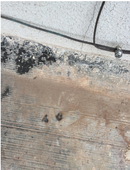
Aterramento fixado na parede atualmente e furo na manta – cobertura bloco D
