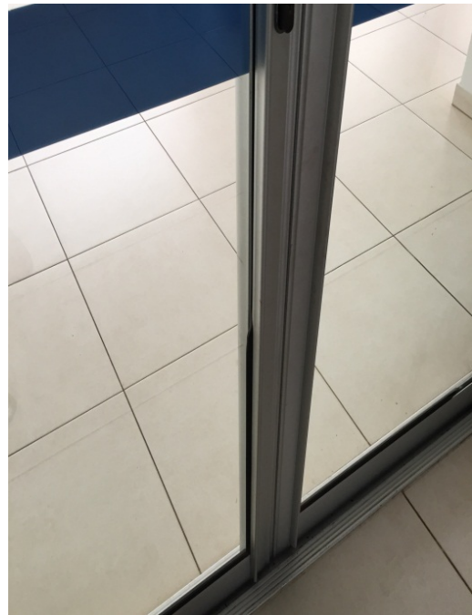
Porta com borracha de fixação do vidro soltando – espaço gourmet
