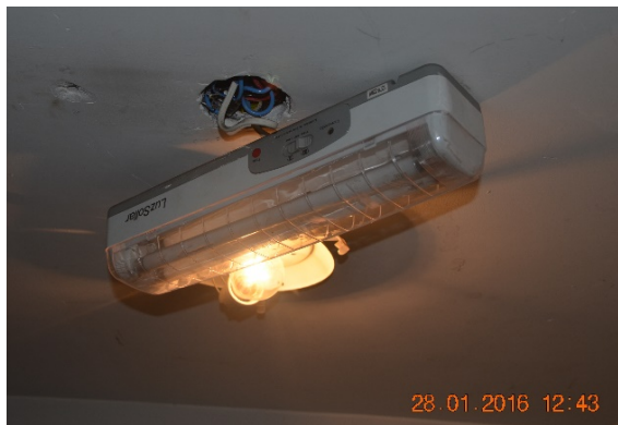
Fiação exposta e luminária quebrada - Escada no mezanino
