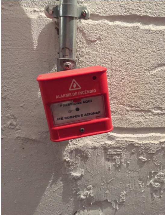
Botoeira do alarme de incêndio solta
