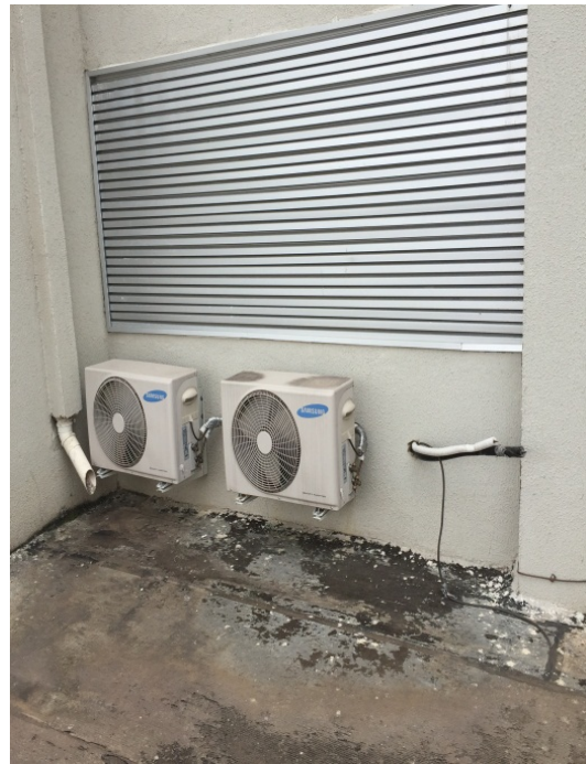
Instalação de ar condicionado na cobertura bloco D
