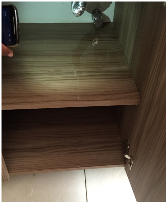
Infiltração no adaptador do filtro, salão de festas bloco D
