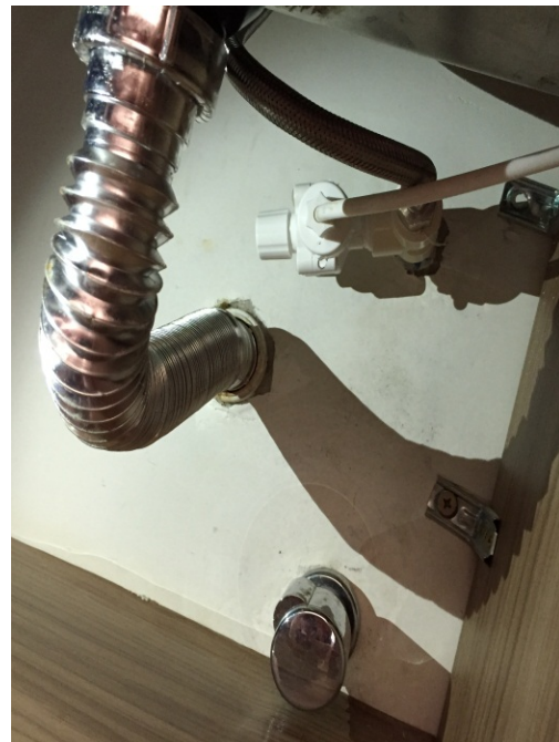
Infiltração no adaptador do filtro, salão de festas bloco D
