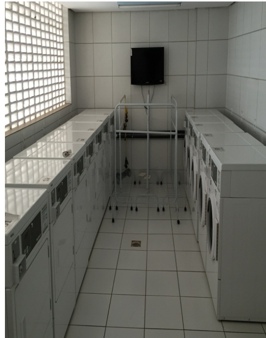
Ausência de acabamento do ralo no piso da lavanderia
