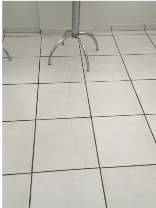
Ausência de rejunte na cerâmica da parede e do piso no refeitório dos funcionários
