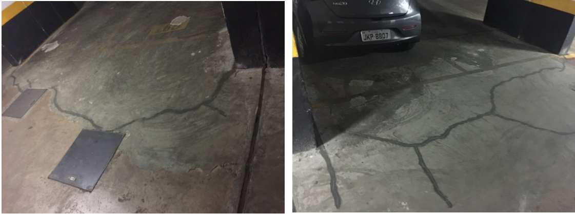
Trincas tratadas na garagem do 1º. Sub solo
