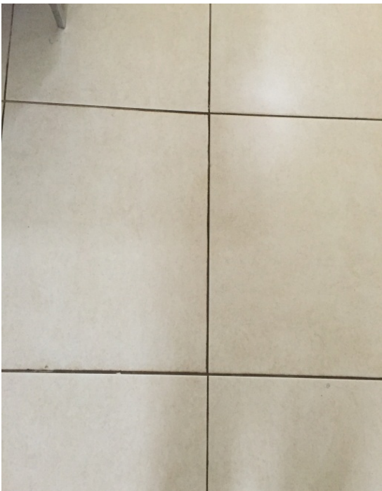
Piso com ausência de rejunte e fissura na parede do Home Officer
