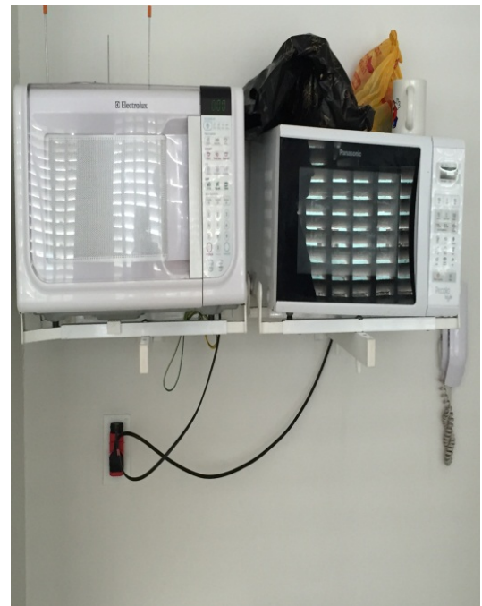
Ligação elétrica contrária a Norma no refeitório dos funcionários
